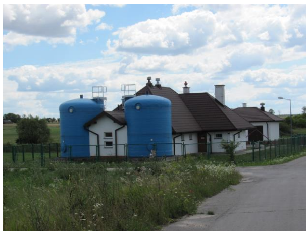
Fot. 40. Oczyszczalnia ścieków w Pawłowie
