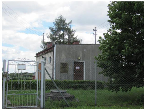
Fot. 41. Oczyszczalnia ścieków w Krasnem
