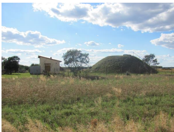
Fot. 39. Ujęcie wody w Wólce Kańskiej Kolonii
