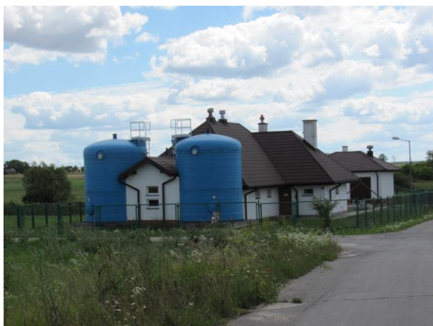
Fot. 40. Oczyszczalnia ścieków w Pawłowie
