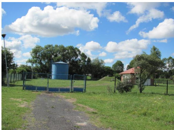
Fot. 38. Ujęcie wody w Pawłowie
